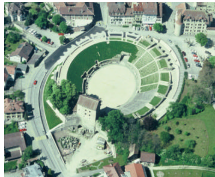
Fig. 1: L'amphithéâtre d'Avenches après restauration en mai 1991. (Photo D. Weidmann – Archéologie cantonale)
